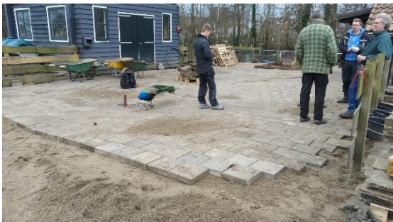
uitvoering diverse werkzaamheden
